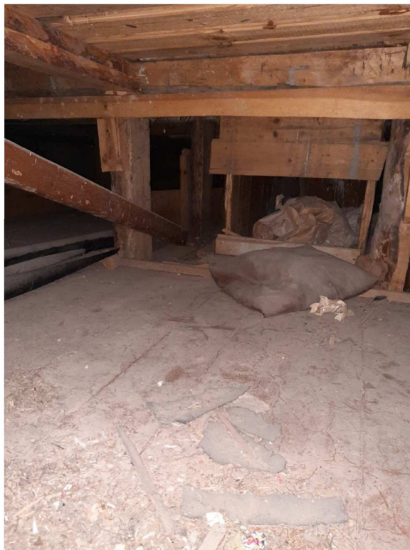
Skatuves nesošās konstrukcijas, virs tām retināts koka dēļu klājs, kokskaidu plāksne un grīdas segums - krāsots grīdas kartons
