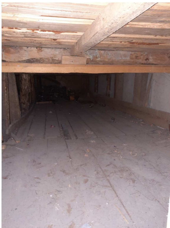
Skatuve izbūvēta no koka konstrukcijām, kur pielietoti dažādu šķēsgriezumu kokmateriāli
