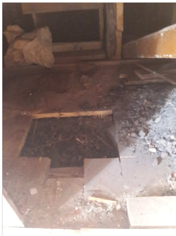
Koka siju pārsegums ar izdedžu siltumizolāciju zem skatuves konstrukcijas.
