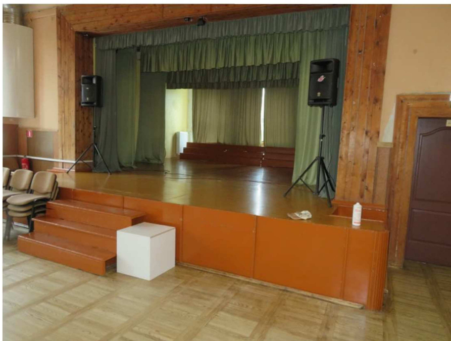
Skatuves priekšējā siena izbūvēta no koka karkasa, kas apšūts ar krāsotiem koka konstrukcijas paneļiem. Skatuves priekšpusē novietotas atsevišķas koka konstrukcijas (pārvietojamas) kāpnēs. Uz skatuves novietoti koka konstrukcijas (pārvietojami) podesti.
